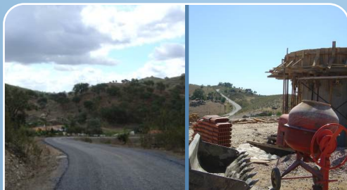
CORTES PEREIRAS - PAVIMENTAÇÃO DE ACESSOS LOCAIS E DEPÓSITO E REDE ÁGUA
