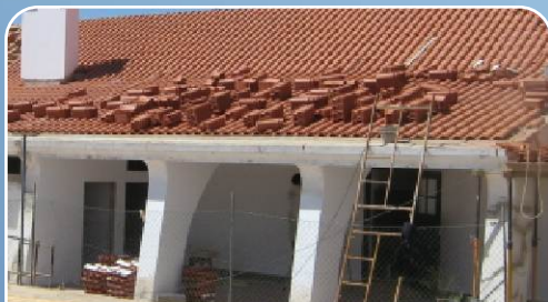
SANTA CLARA-A-VELHA - REPARAÇÃO DA ESCOLA
